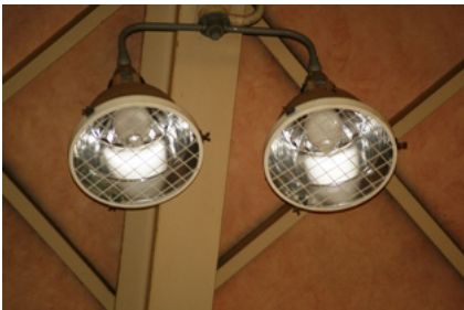
これをLED照明に取り換えています。
